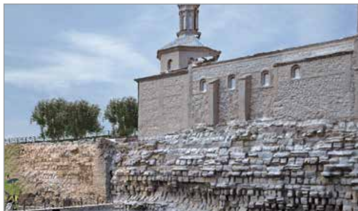
FIG. 135. Malla 3D transformada en formato PDF3D de la Presa romana de Muel (Zaragoza).
